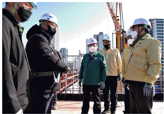
이원재 국토교통부 제1차관이 2일 세종시 한국토지주택공사 행복주택 건설 현장을 방문, 화물연대 집단승거부예 따른 건설공사 피해 현황을 점검하고 있다.
